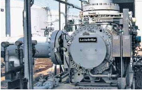
In einer Pumpenstation von Exxon Mobil, Afrika, sorgt unsere **SHV-D4/170-E1** (API-Plan 54) als Doppeldichtung für den erfolgreichen Lauf einer zweispindeligen Schraubenspindel-Multiphasenpumpe von Leistritz. Betriebsbedingungen: Gasanteil ... 99 %; p = 60 bar (870 PSI); t = 54 °C (129 °F); n = 1.200 min<sup>-1</sup>.
