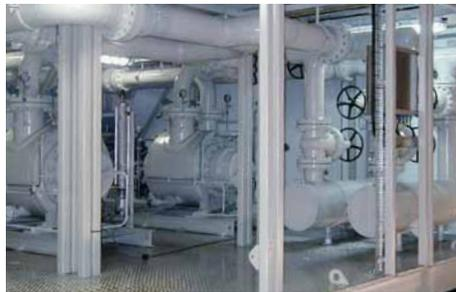
In Westsibirien, beim Betreiber Rosneft, wird eine Rosscor Schraubenspindel-Multiphasenpumpe mit einer EagleBurgmann Cartridge **SH6/125-EF1** (API-Plan 32) Einzeldichtung abgedichtet. Betriebsbedingungen: Gasanteil ... 97 %; p ... 40 bar (580 PSI); t ... 65 °C (149 °F); n = 2.200 min<sup>-1</sup>.
