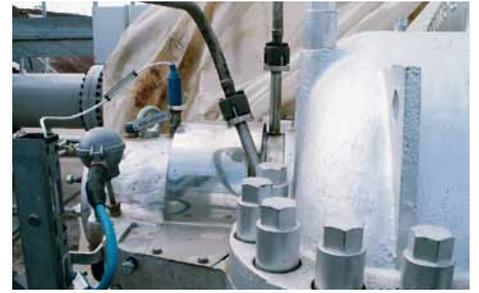
Bei BTC (Baku-Tiflis-Ceyhan) in der Türkei sind in Pipeline-pumpen der Ruhrpumpen GmbH EagleBurgmann **SHF3-D/135-E1** Doppeldichtungen und **SHV-D3/170-E1** eingesetzt. Betriebsbedingungen:  $p = 1 \text{ bar (15 PSI)}$ ;  $t = 5 \text{ °C} \dots 40 \text{ °C (41 °F} \dots 104 \text{ °F)}$ ;  $n = 1.490 \text{ min}^{-1}$ ; Doppeldichtung:  $p = 74 \text{ bar (1.073 PSI)}$ ;  $t = 30 \text{ °C (86 °F)}$ ;  $n = 1.800 \text{ min}^{-1}$ .
