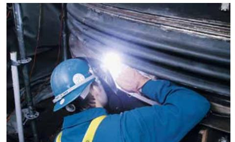
In einer Offshoreanlage in der Nordsee wurde ein übergroßer **Clamshell-Kompensator** aus Inconel® 625 installiert. Er ummantelt und schützt den schadhaft gewordenen Balg (DN 2000) einer Turbine. Betriebsbedingungen: p = 1 bar (14.5 PSI); t = 450 °C (842 °F).
