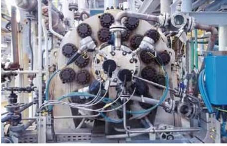
EagleBurgmann Neuentwicklung einer Pumpendichtung für dynamische Drücke von bis zu 600 bar, geliefert für eine FPSO im Tupi-Ölfeld vor der brasilianischen Küste. Die Tripeldichtung vom Typ **SHVF-D11/100-KB1** wird in einer CO<sub>2</sub>-Injektionspumpe eingesetzt. Medium: Überkritisches Kohlendioxid; Betriebsbedingungen: p = 481 bar (6.975 PSI); t = 40 °C ... 70 °C (104 °F ... 158 °F); n = 3.600 min<sup>-1</sup>.
