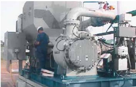
Auf dem Zuata-Feld, Venezuela, ist in einer Bornemann Schraubenspindel-Multiphasenpumpe seit 1998 die EagleBurgmann **HSHJ97GS1/100-E1** (API-Plan 32) Einzeldichtung im Einsatz. Betriebsbedingungen: Gasanteil ... 98 %; p ... 25 bar (363 PSI); t = 93 °C (199 °F); n = 1.660 min<sup>-1</sup>.
