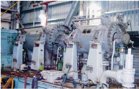
Bei PEMEX (Petróleos Mexicanos) wird seit 2005 in einem Sauggaskompressor von Dresser Rand die EagleBurgmann **DGS20/170-TA3-U** in Kombination mit dem Versorgungssystem **13-SMS-2-DGS20** eingesetzt. Betriebsbedingungen: p ... 36 bar (522 PSI); t = 50 °C ... 130 °C (122 °F ... 266 °F); n = 8.295 min<sup>-1</sup>.
