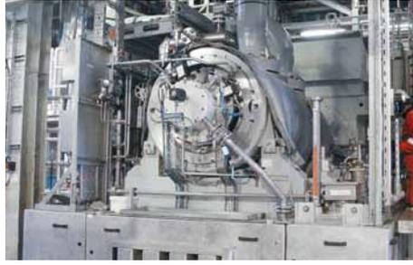
In Norwegen, auf der Brage-Plattform von Statoil-Hydro, kommt in einer Wasserinjektionspumpe von Aker-Kvaerner eine EagleBurgmann **SHFV-D4/160-E1-A3** als Doppeldichtung zum Einsatz. Betriebsbedingungen: p = 44 bar (638 PSI); t = 7 °C ... 80 °C (45 °F ... 176 °F); n = 3.585 min<sup>-1</sup>.
