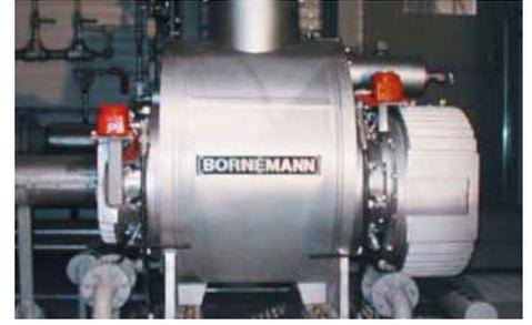
Beim Betreiber CNRL in der Cold Lake Region in Kanada sind in über 140 Pumpen ca. 500 EagleBurgmann **HSHJ92S1/80-E3** Dichtungen in Betrieb. Die Einzeldichtungen sind in Bornemann Schraubenspindel-Multiphasenpumpen eingesetzt. Betriebsbedingungen: Gasanteil ... 95 %; p ... 6 bar (87 PSI); t = 150 °C (302 °F); n = 1.200 min<sup>-1</sup>.
