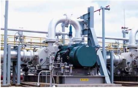
Für Petropiar/Ameriven (PDVSA-Chevron Texaco) in Venezuela lieferte EagleBurgmann Gleitringdichtungen und ein Umrüstungskonzept. Das Rohöl wird nun trotz der hohen Viskosität zuverlässig mit einer **HSHJ47GS6/140-E1** in einer Schraubenspindel-pumpe von Bornemann Pumps abgedichtet. Betriebsbedingungen:  $p \dots 50 \text{ bar (725 PSI)}$ ;  $t \dots 60 \text{ °C (140 °F)}$ ;  $n = 1.185 \text{ min}^{-1}$ .
