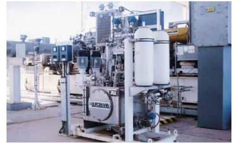
Doppeldichtung **SHFV-D3/140-E3** mit Versorgungssystem **SPN120**, installiert in einer Wasserinjektionspumpe von Sulzer Pumps bei PDO (Petroleum Development Oman) im Oman. Betriebsbedingungen: p = 17 ... 22 bar (247 ... 319 PSI); t = 30 °C ... 80 °C (86 °F ... 176 °F); n = 4.700 min<sup>-1</sup>.
