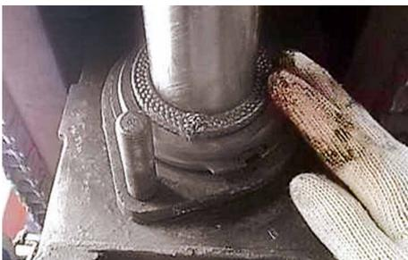
Im Kohlekraftwerk PT.Ipmomi in Indonesien müssen heiße Abgase mit Flugasche und Dampf innerhalb eines Rußbläfers abgedichtet werden. Die Stopfbuchspackungen **Isartherm® 6011A** und **Isartherm®-Flex 6050** tragen zu einem zuverlässigen und sicheren Betrieb bei. Betriebsbedingungen:  $p = 40 \text{ bar}$  (580 PSI);  $t = 400 \text{ °C}$  (752 °F).
