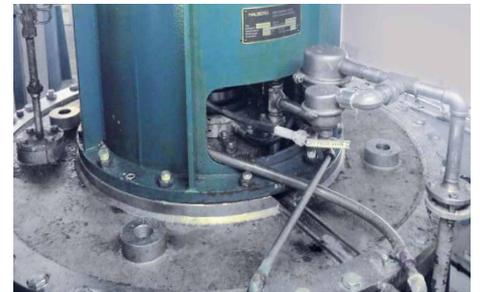
Die geteilte Gleitringdichtung vom Typ **HGH210/225-E1** wird zur Abdichtung einer Hauptkühlwasserpumpe im KNG Kraftwerk in Rostock eingesetzt. Betriebsbedingungen:  $p = 2,25 \text{ bar}$  (23,63 PSI);  $t = 25 \text{ °C}$  (77 °F);  $n = 490 \text{ min}^{-1}$ ; Medium: Brackwasser mit Sand.
