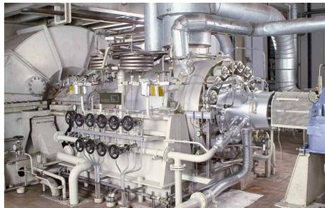
Im EnBW Kraftwerk in Heilbronn, Deutschland, wird eine KSB Speisewasserpumpe vom Typ CHTA140 mit einer Gleitringdichtung vom Typ **SHV1/200-E1** abgedichtet. Betriebsbedingungen:  $p = 30 \text{ bar}$  (435 PSI);  $t = 180 \text{ °C}$  (356 °F);  $n = 5.180 \text{ min}^{-1}$ .
