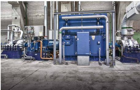
Das RWE Kraftwerk in Niederaußem, Deutschland, verwendet zum Transport des Speisewassers eine Weller-Pumpe. Bei der Abdichtung kommt die Gleitringdichtung **SAPV1/138-E2** zusammen mit einem Dichtungsversorgungssystem vom Typ **SPF9025/A005-V1** zum Einsatz. Betriebsbedingungen:  $p = 20,2 \dots 27,5 \text{ bar}$  (293 ... 399 PSI);  $t = 177 \dots 201 \text{ °C}$  (351 ... 394 °F);  $n = 1.000 \dots 5.100 \text{ min}^{-1}$ .
