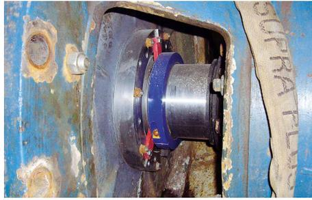
Abrasive Kalkmilchsuspension wird im RWE Kraftwerk Frimmersdorf, Deutschland, mit einer Suspensionsförderpumpe transportiert. Für die Abdichtung sorgt dabei eine Gleitringdichtung vom Typ **HR325/270-G11-E6**. Betriebsbedingungen:  $p = 3 \dots 4,5 \text{ bar}$  (44 ... 65 PSI);  $t = 50 \text{ °C}$  (122 °F);  $n = 890 \text{ min}^{-1}$ .
