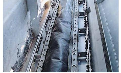
Für eine Rauchgasleitung im EGAT Wang Noi Kraftwerk in Thailand werden **Fluastal** Kompensatoren in der Größe 9 x 5 m aus speziellem Gewebe eingesetzt. Betriebsbedingungen:  $p = 0,074 \text{ bar}$  (1,07 PSI);  $t = 580 \text{ °C}$  (1.076 °F).
